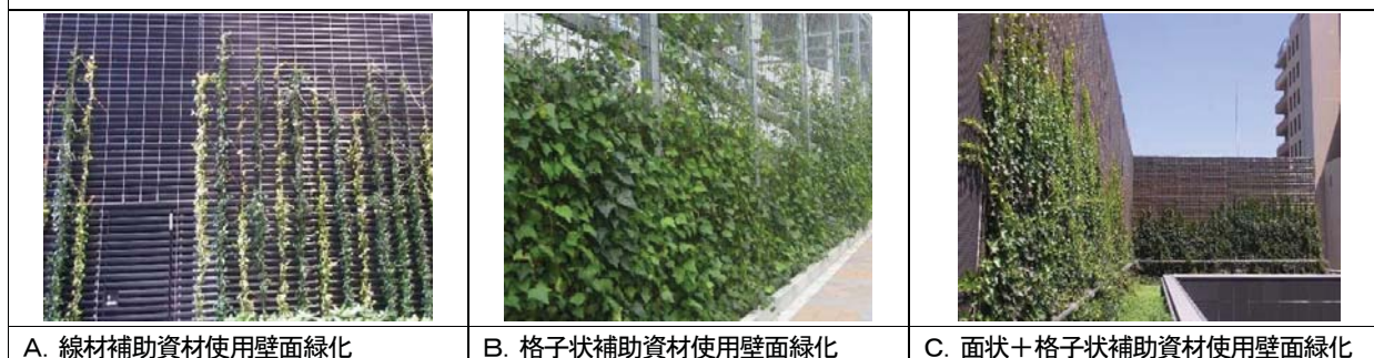
A. 線材補助資材使用壁面緑化
